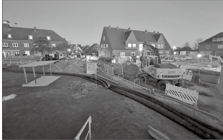
Die Tiefbauarbeiten im Mühlenquartier sind in vollem Gange. Foto: Sykora
