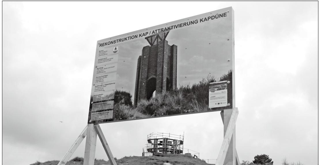
(syk) – Bald sieht das Norderneyer Kap wieder so aus wie auf dem Schild. Derzeit werden die Säulen mit Beton gegossen. Sobald dieser ausgetrocknet ist, werden Klinkersteine befestigt, die dem Vorgänger ähneln. Das hölzerne Dreieck, das sich auf dem Kopf stehend darauf befindet, wird von der Firma Köhn nach Vorlage und Zeichnungen komplett neu gebaut.
