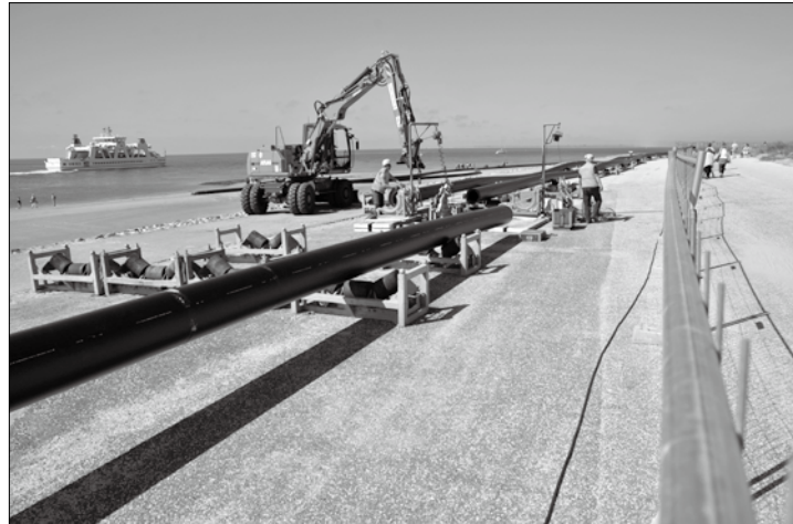
In diese Rohre kommen Stromkabel.
